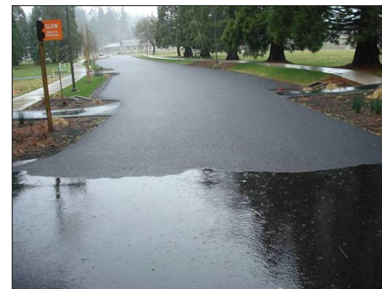
透水路面实例图
